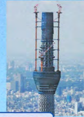
安全ネットで覆われた作業現場
