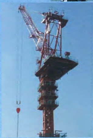
一番大きなクレーンは1回に30tを吊り上げる能力をもち、300m吊り上げるのに10分を要する。第1展望台までの鉄骨組立てには3基が用いられた
