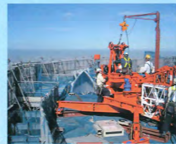
安全ネットで覆われた作業現場
