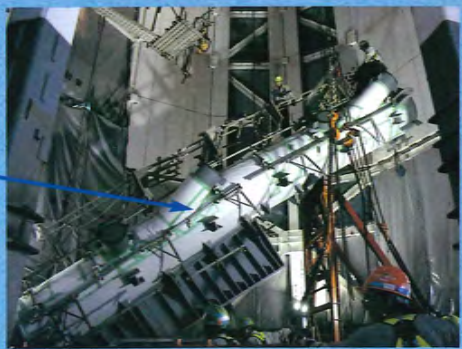
タワーの中心の空洞内で吊り上げられるゲイン塔
